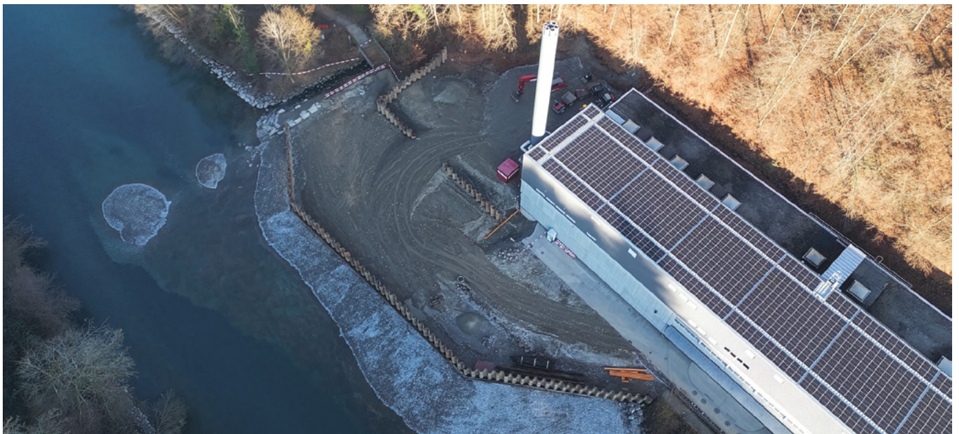
Installationsplattform in der Aare zum Bau der Anlage zur Elimination von organischen Spurenstoffen.
